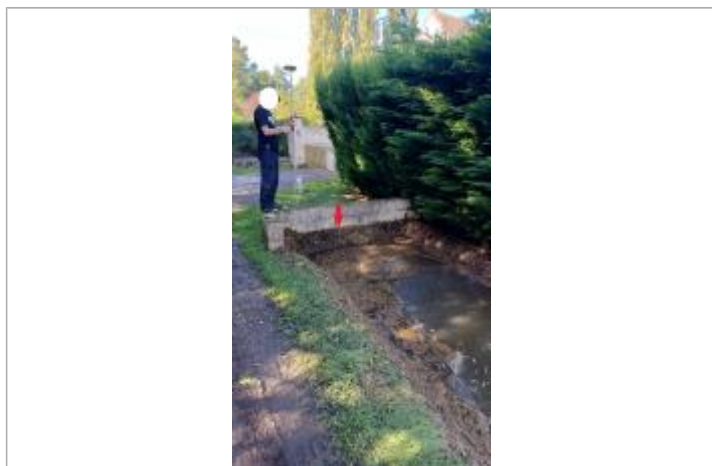
Laisse de crue à -38 cm/ haut du muret.
