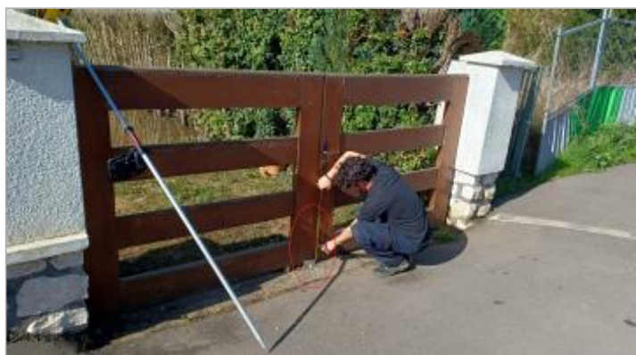
Laisse de crue à 15 cm/sol.
