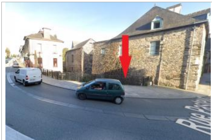
Pont du Rachapt ou de l'hôpital
