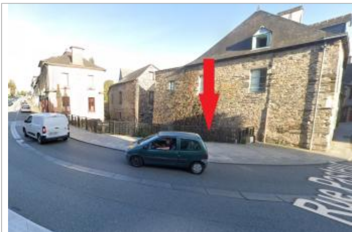
Pont du Rachapt ou de l'hôpital
