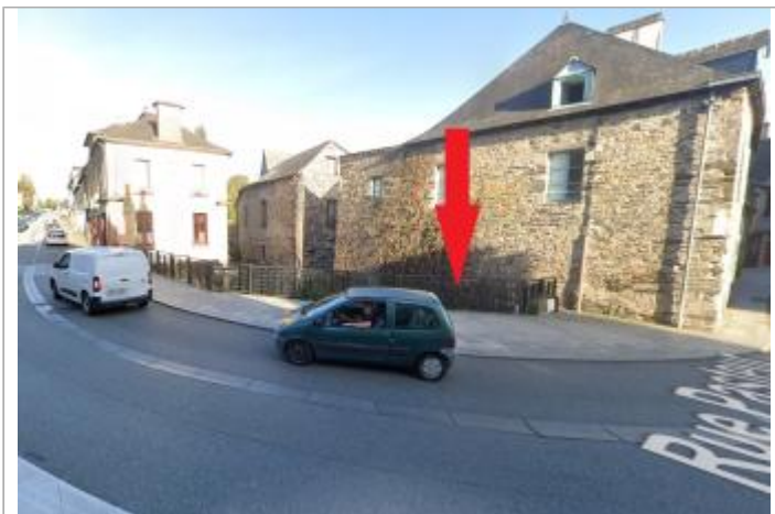
Pont du Rachapt ou de l'hôpital
