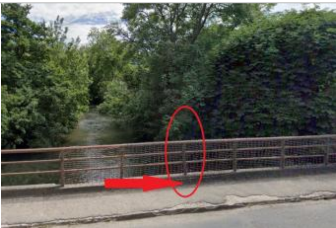
L'eau atteint le niveau -271.5 cm/tablier du pont.
