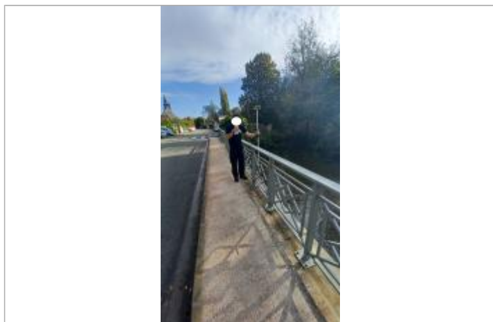
Nivellement du tablier du pont. (au milieu du pont coté amont)
