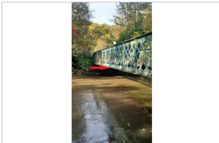
Vue du pont depuis la rue des Passerelles.
