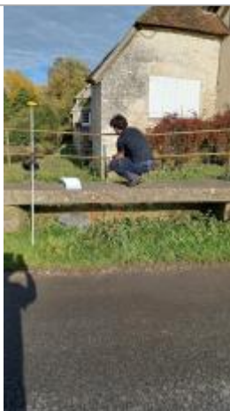
Laisse de crue à 30 cm/sol
