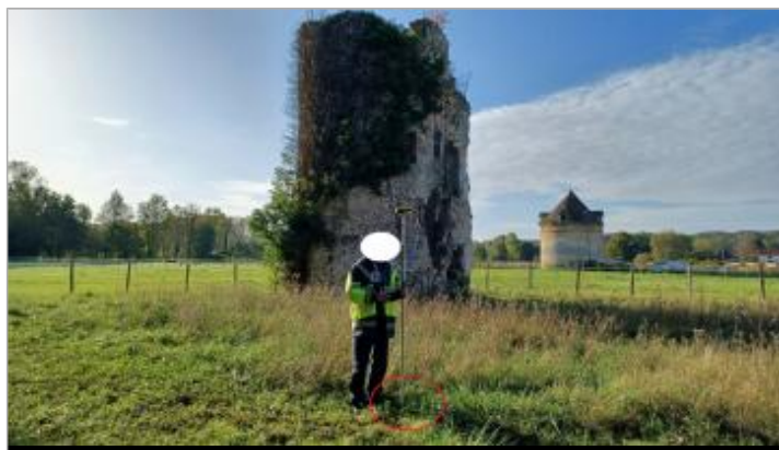
Laisse de crue au sol
