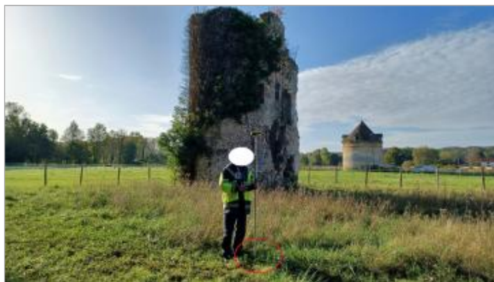
Laisse de crue au sol
