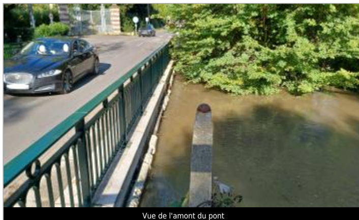
Vue de l'amont du pont
