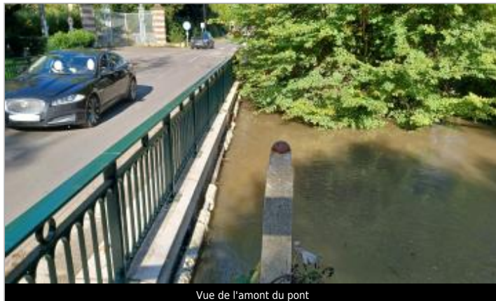
Vue de l'amont du pont
