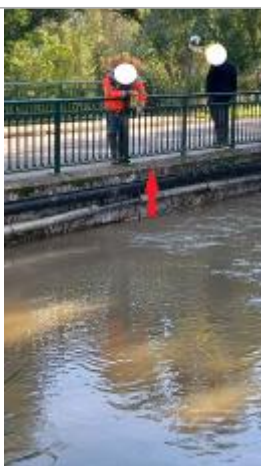
Niveau de l'eau à -77 cm du tablier du pont.
