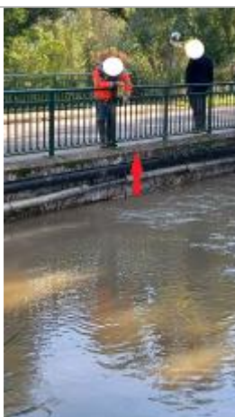
Niveau de l'eau à -77 cm du tablier du pont.
