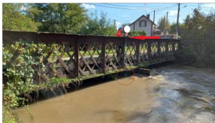
L'eau atteint le niveau -203 cm en dessous du haut du garde corps du pont.
