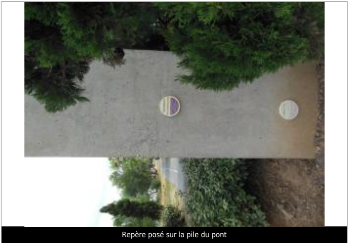
Repère posé sur la pile du pont
