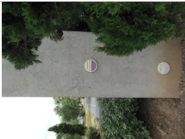
Repère posé sur la pile du pont
