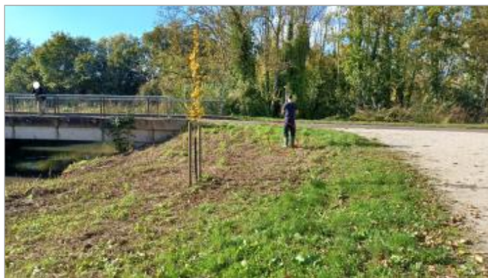
Laisse de crue au sol.
