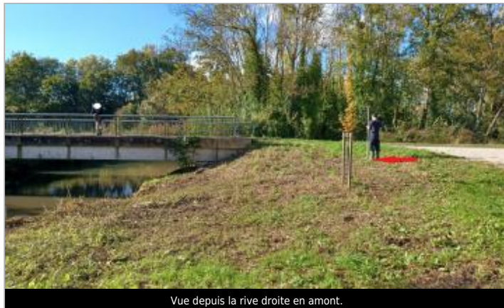
Vue depuis la rive droite en amont.
