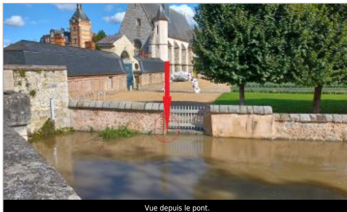
Vue depuis le pont.
