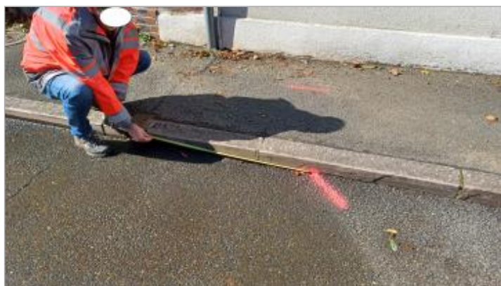
Laisse de crue au sol à 106 cm de l'avaloir
