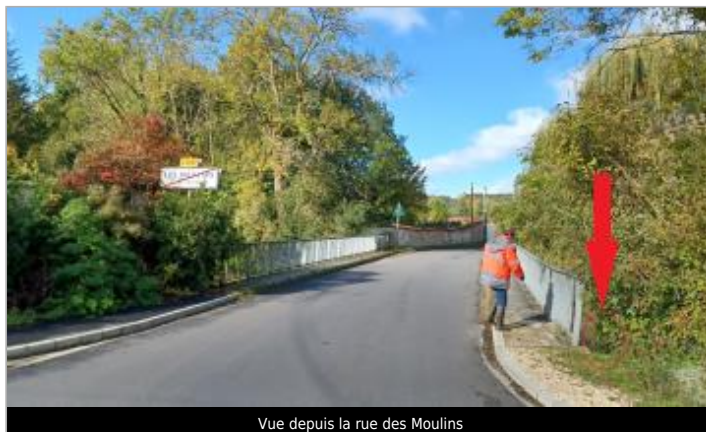
Vue depuis la rue des Moulins
