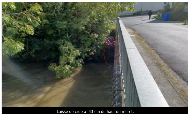
Laisse de crue à -43 cm du haut du muret.
