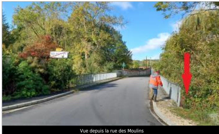
Vue depuis la rue des Moulins
