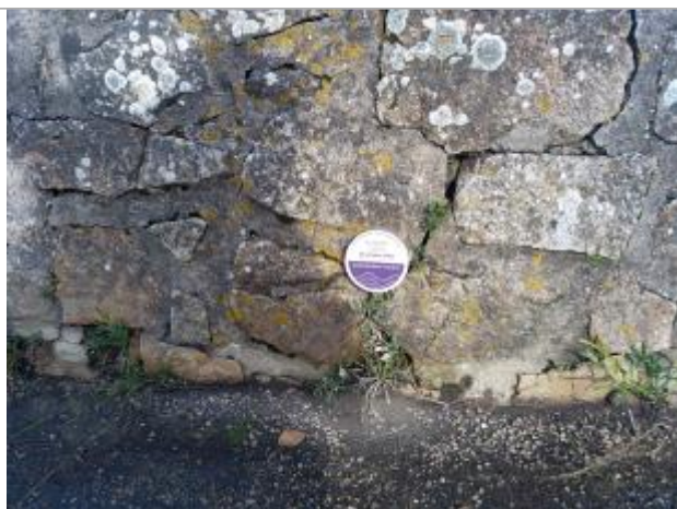
Repère de submersion moulin de Pen Castel tempête Céline 28/10/2023
