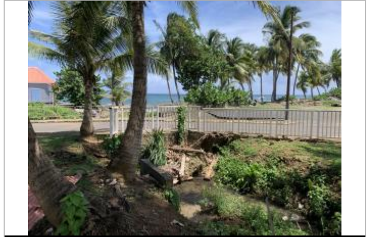
Vue à l'amont du pont
