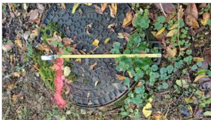
Laisse de crue à 59 cm de la rotule de la plaque d'égout.
