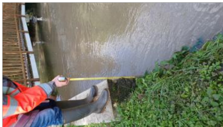
L'eau est arrivée à 39 cm du haut du muret.
