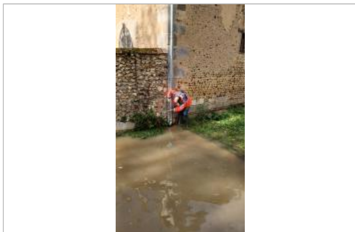
Laisse de crue à 9 cm/sol.
