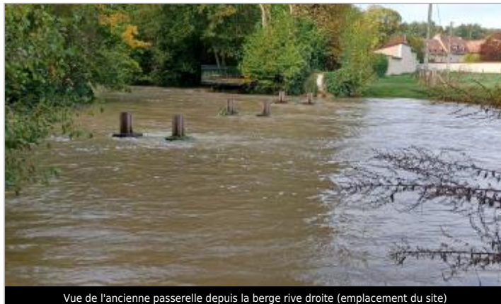
Vue de l'ancienne passerelle depuis la berge rive droite (emplacement du site)
