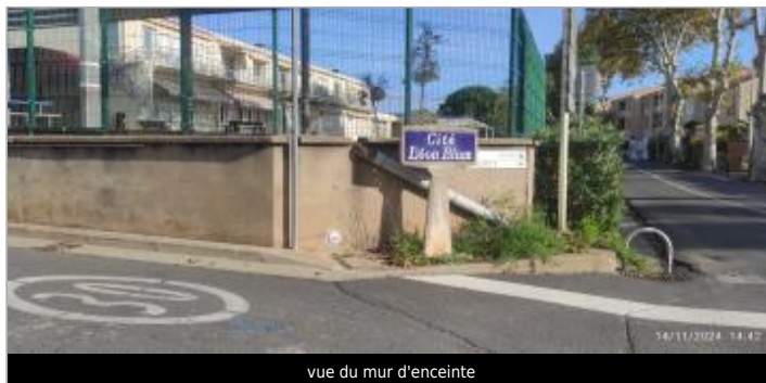
vue du mur d'enceinte
