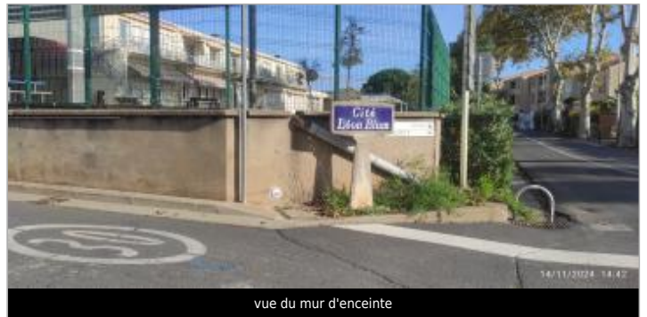
vue du mur d'enceinte
