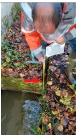
Laisse de crue à -74.5 cm du haut du rebord en ciment.
