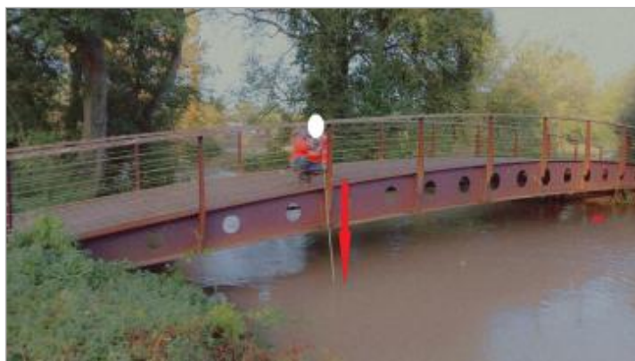
Niveau de l'eau à 144.5 cm en dessous du sol de la passerelle.
