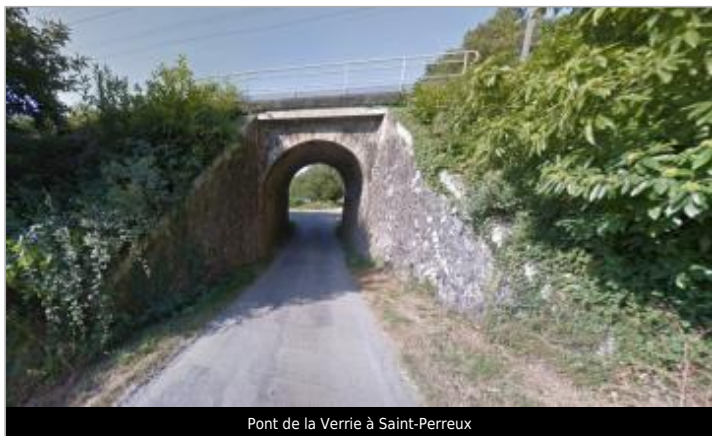
Pont de la Verrie à Saint-Perreux
