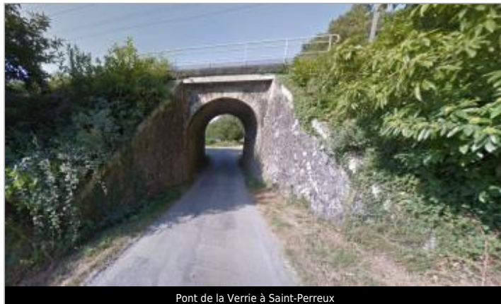
Pont de la Verrie à Saint-Perreux
