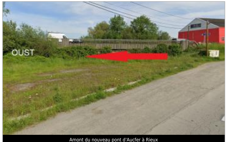
Amont du nouveau pont d'Aucfer à Rieux
