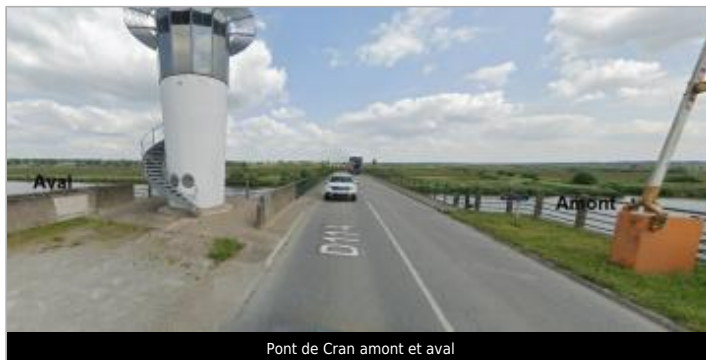
Pont de Cran amont et aval
