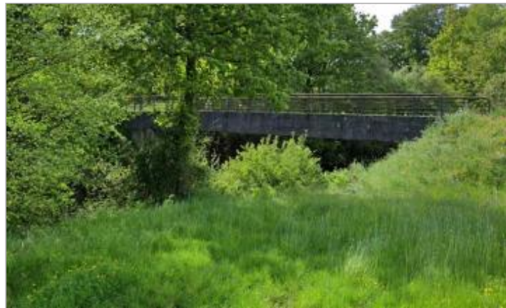
Pont de Bonard sur l'Arz à Saint-Jean-de-la-Poterie
