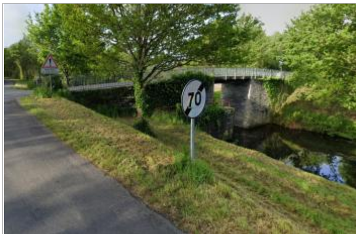
Pont sur le canal de Nantes à Brest à Quinsignac en Saint-Nicolas-de-Redon
