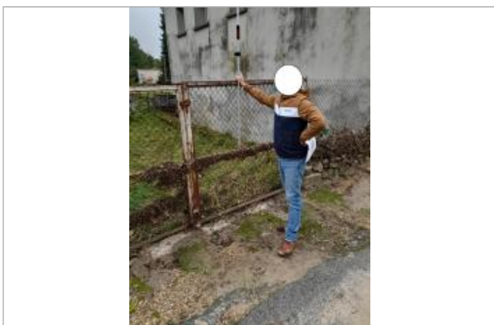
Déôt de végétaux sur la porte grillagée dans la rue du Vieux Moulin
