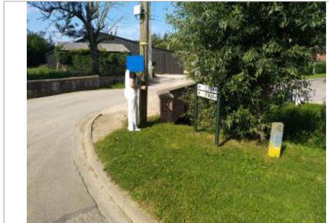
Le site est un poteau électrique en bois
