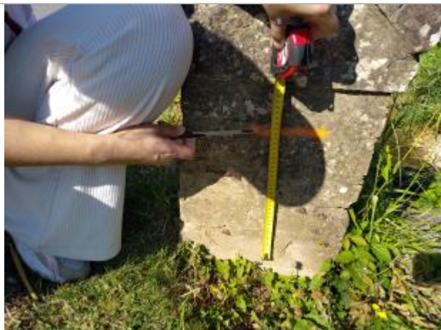
Le repère est situé au pied du muret.
