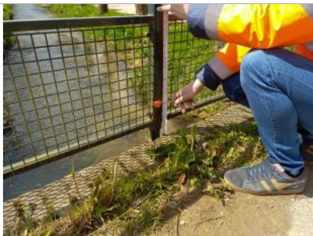
Le repère est localisé sur un garde-corps.
