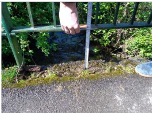
Le repère est localisé sur un garde-corps.
