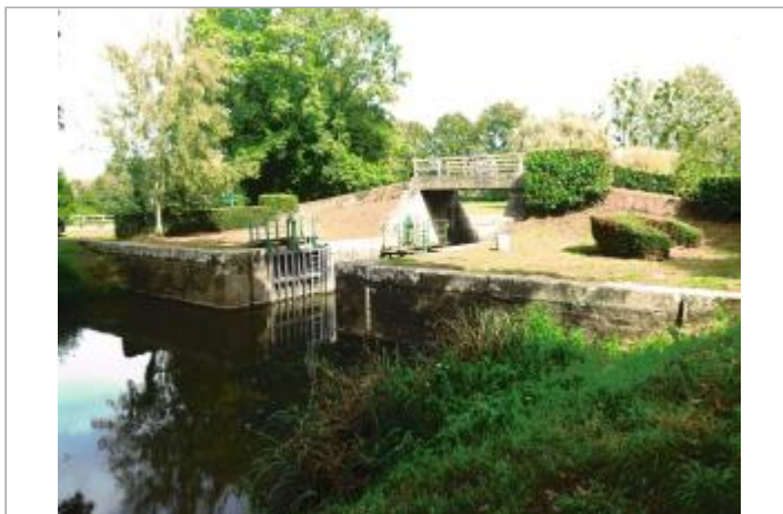
Vue amont de l'ancienne écluse de Limur
