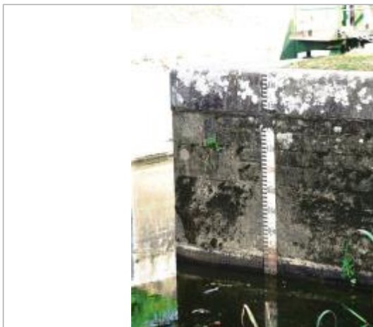
Echelle amont de l'ancienne écluse de Limur
