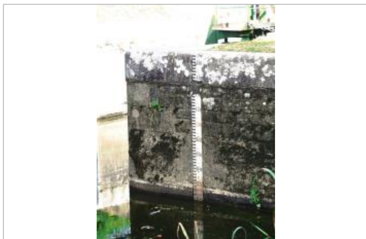
Echelle amont de l'ancienne écluse de Limur
