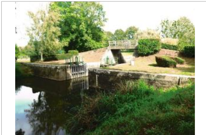
Vue amont de l'ancienne écluse de Limur
