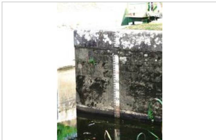
Echelle amont de l'ancienne écluse de Limur
