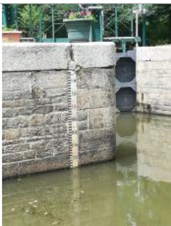
Echelle limnimétrique aval de l'écluse de la Maclais
