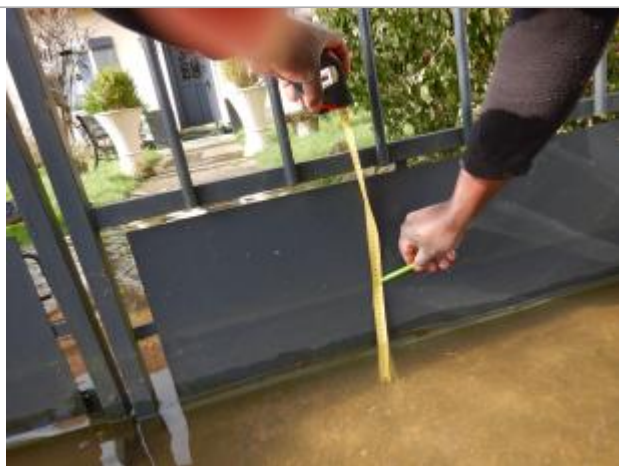
Le repère est localisé au pied d'un portail.
