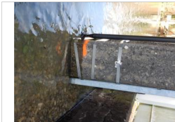
Le repère est localisé au pied d'un poteau électrique.
