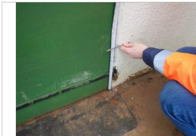
Le repère est localisé au pied d'une porte de garage.
