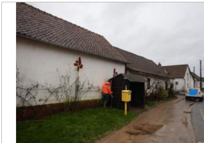
Le site est le mur d'une cahute d'arrêt de bus.
