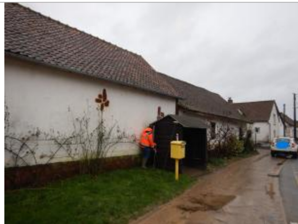
Le site est le mur d'une cahute d'arrêt de bus.
