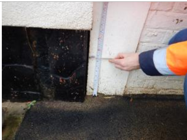
Le repère est au pieds d'un poteau en béton.
