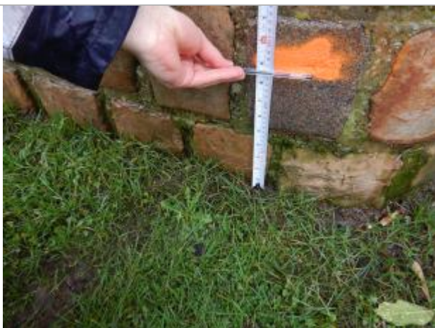
Le repère est localisé sur un poteau en pierre.
